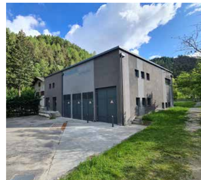
Das Energiewerk Suldenbach
