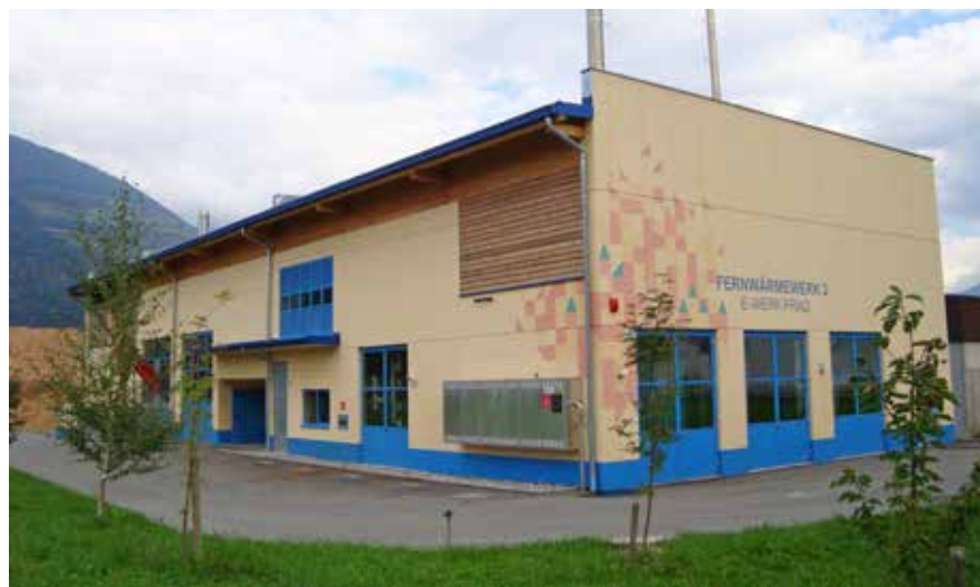
Das Prader Fernwärmewerk 2
