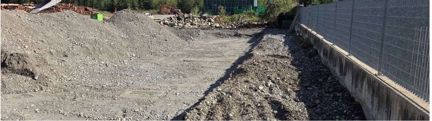
Seit 14. September laufen die Tiefbauarbeiten. Bis Mitte Oktober werden die Fundamente für die drei Container vorbereitet.
