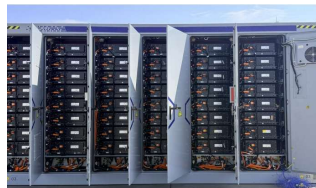
Die Speichercontainer: außen kompakt, innen mit LFP-Batteriemodulen aufgebaut.
