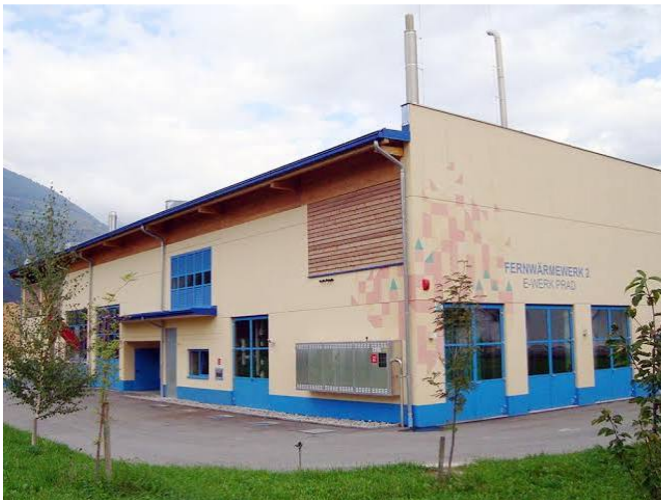
Die Fernwärmezentrale des E-Werk Prad.
